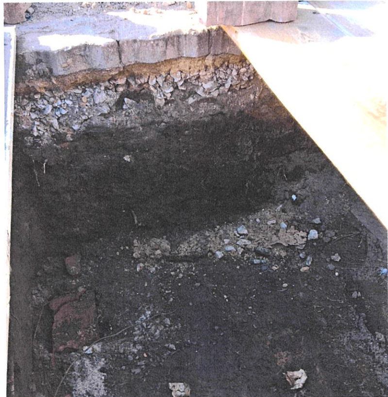
Fot.2. Odkrywka kabli. Widoczny przekrój warstw pod chodnikiem i ułożone cegły zabezpieczające kable przed uszkodzeniem.
